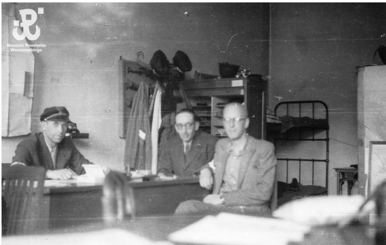
Fotografia z Powstania Warszawskiego. Powiśle. Zdjęcie wykonane w elektrowni (w małym budynku przy bramie od ul. Zajęczej) pomiędzy 3.08 a 5.09.1944 r. Od lewej siedzą: Stanisław Skibniewski "Cubryna" (05.08.1901-03.05.1958) - kapitan AK, dowódca oddziału, który w Powstaniu zdobył elektrownię i potem dowódca załogi elektrowni. Inżynier elektryk, przed wojną i w czasie okupacji dyrektor techniczny elektrowni. Pochowany na Cmentarzu Wojskowym na Powązkach. Jan Piasecki - inżynier elektryk, pracownik elektrowni warszawskiej. Tadeusz Kahl "Kowalski" - inżynier elektryk, pracownik elektrowni, wówczas porucznik AK, zastępca Skibniewskiego. Kahl był szkolnym kolegą Waclawa Lotha ze szkoły im. Reja w Warszawie (razem zdawali maturę w 1925 r.). Fot: Waclaw Loth „Kupiec”, Archiwum zdjęć Muzeum Powstania Warszawskiego, nr inwentarzowy: MPW-IP/5447
